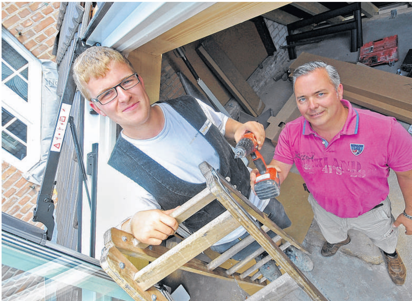
Philipp Oostendorp und sein Chef René Schenk auf der Baustelle am Rosenhof in Haffen.
